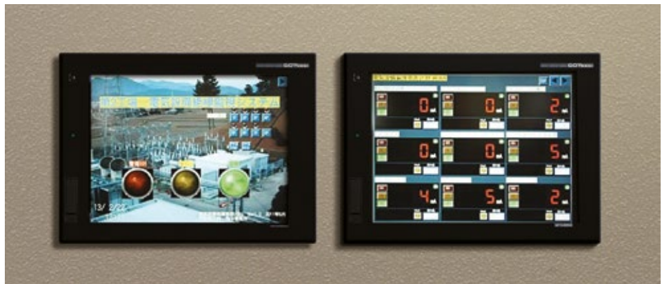
GOT'da ana ekran (solda) ve bireysel izleme sonuçları ekranı (sağda) gösterilmiştir. Ayarlanan eşik değerlerinin üzerindeki değerler sarı veya kırmızı yanar.
